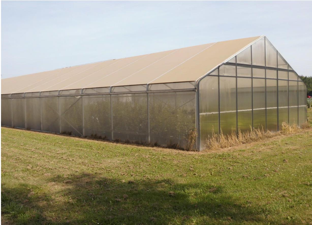
**Abb. 11: Mit Mitteln des Landes NRW wurde 1999 beim Pflanzenschutzamt in Bonn für die Vorstufenpflanzen des Landesmuttergartens ein blattlaussicheres Sarangewächshaus errichtet**
