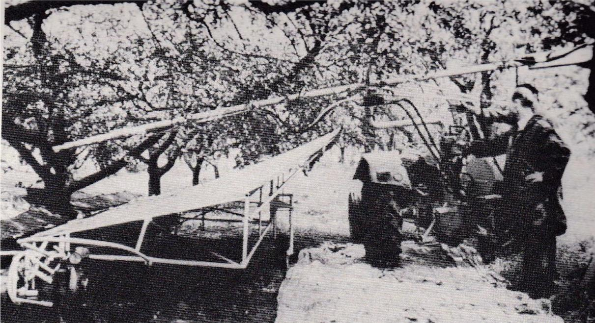
**Abb. 6: Der sog. Göttinger Schüttler System Hardenberg – entwickelt in den 60er Jahren – zur Ernte von Baumobst (Leihgabe des Instituts für Obstbau und Baumschule der TH Hannover)(Foto: LK – GVB 1974)**
